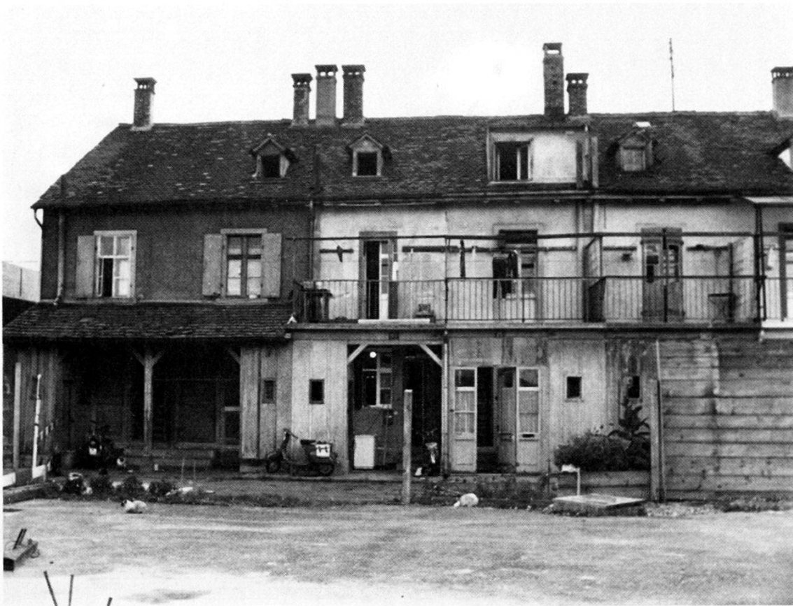
Abb. 2. Basel, In der Breite 15-19, erbaut 1855/56.
