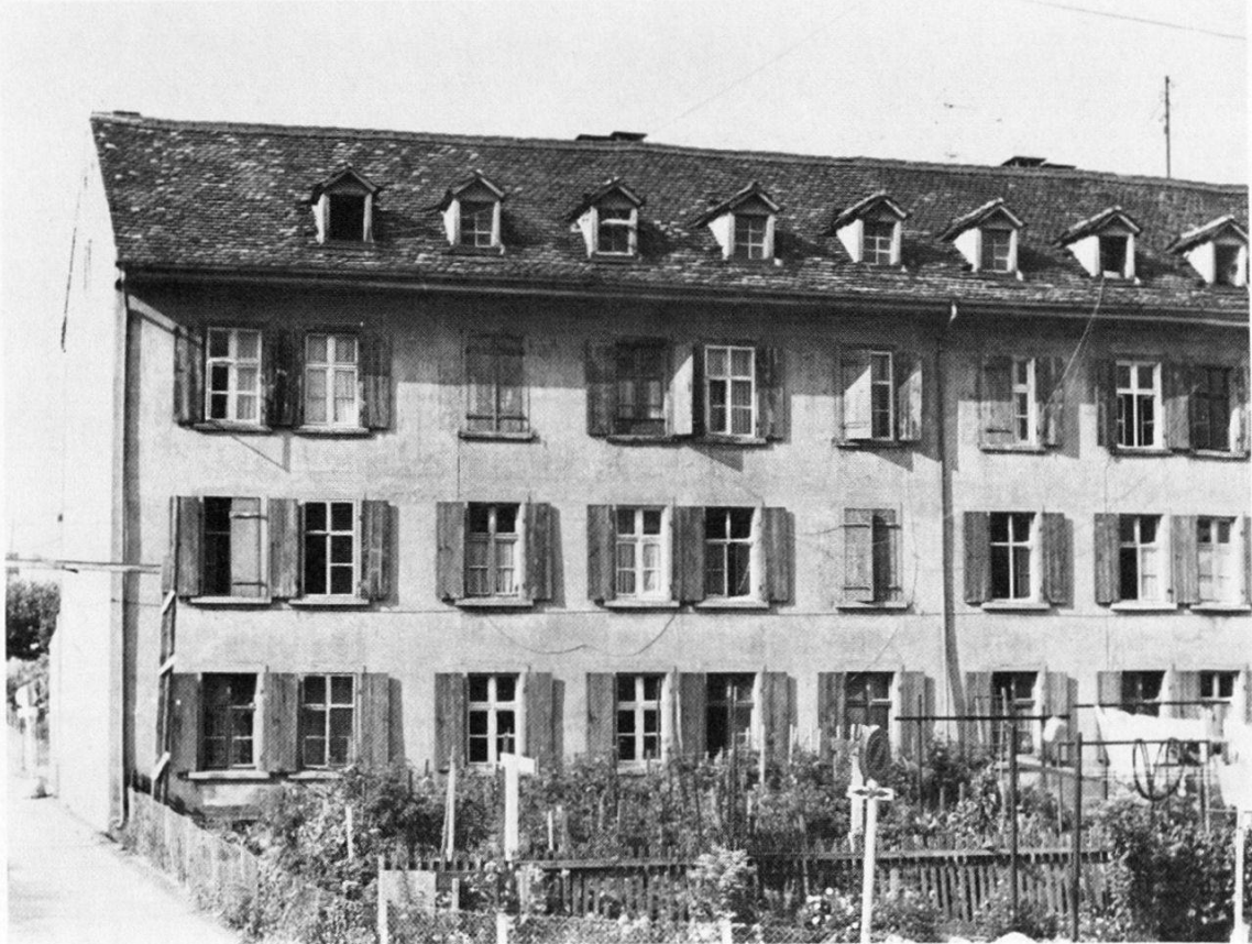
Abb. 3. Basel, In der Breite 9-13, erbaut 1856/57.
