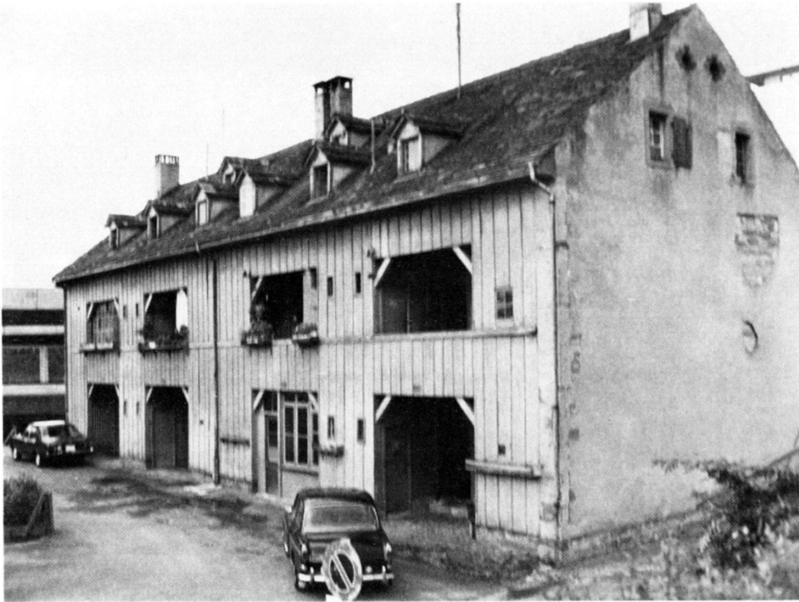
Abb. 1. Basel, In der Breite 1-7, erbaut 1854/55.
