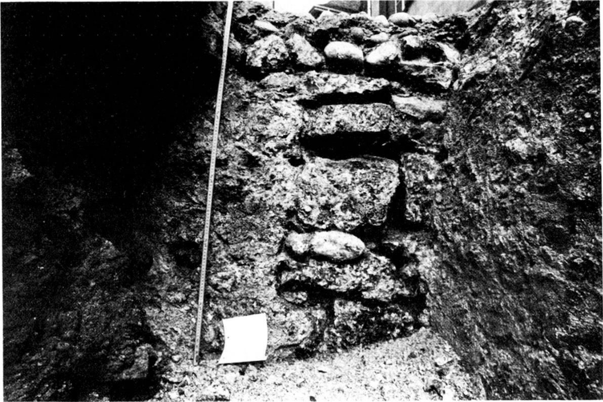
Tafel I (oben). Schlüsselberg 9-17: Keller einer mittelalterlichen Liegenschaft. Die Mauer in der Bildmitte liegt auf der Flucht der spätrömischen Kastellmauer (siehe Abb. 2). - Foto: R. Keller.
