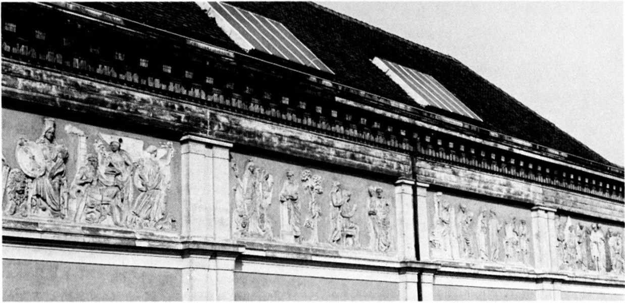
Abb. 10a. Teilansicht der Fassade (Aufnahme 1978).
