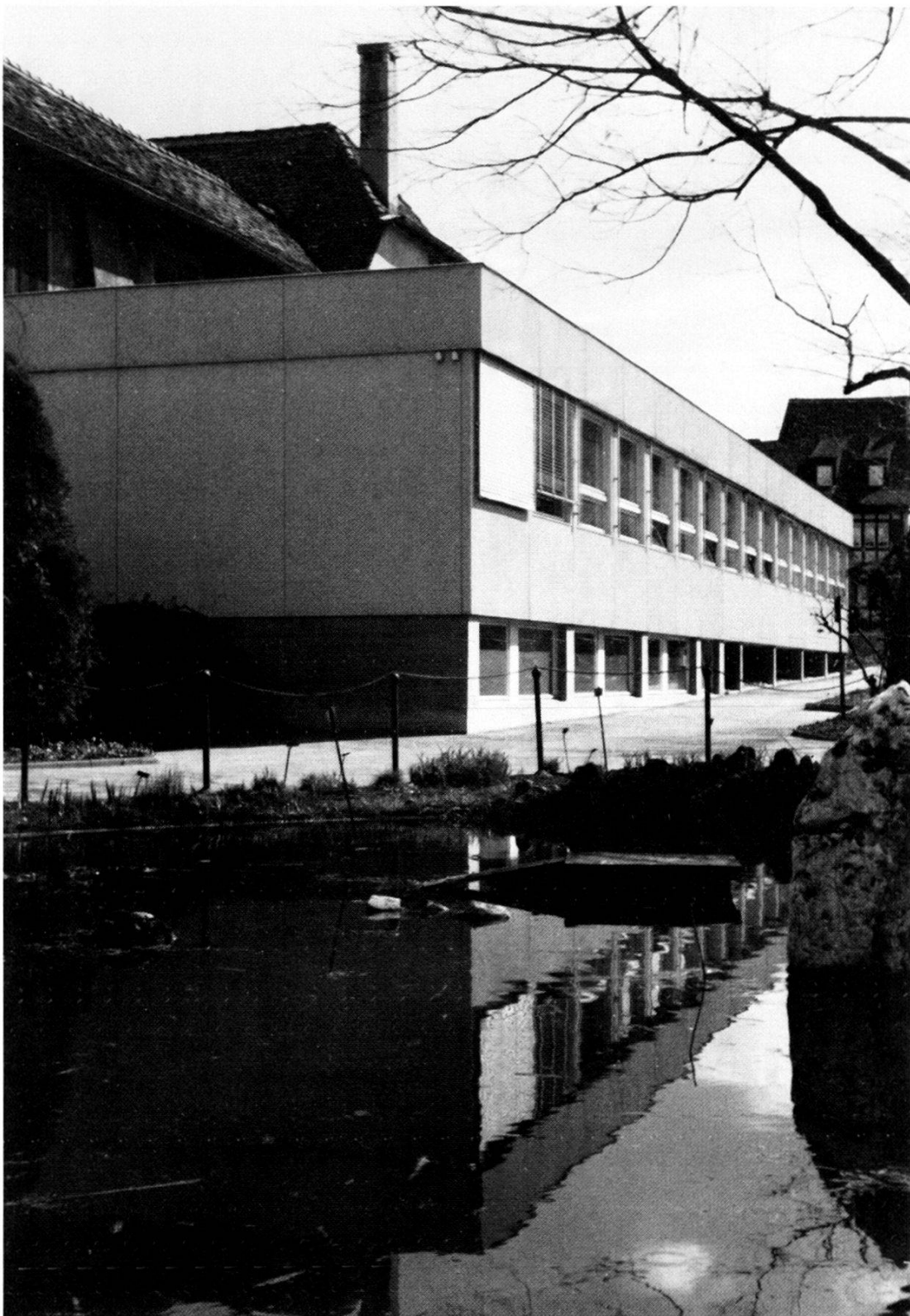
Abb. 22. Ansicht von Norden (Botanischer Garten). Heutige Situation. Der 1966 errichtete Labortrakt der Rückfront des Stachelschützenhauses angebaut. Im Vordergrund ein Weiher des Botanischen Gartens. (Foto: Institut für Mikrobiologie und Hygiene)
