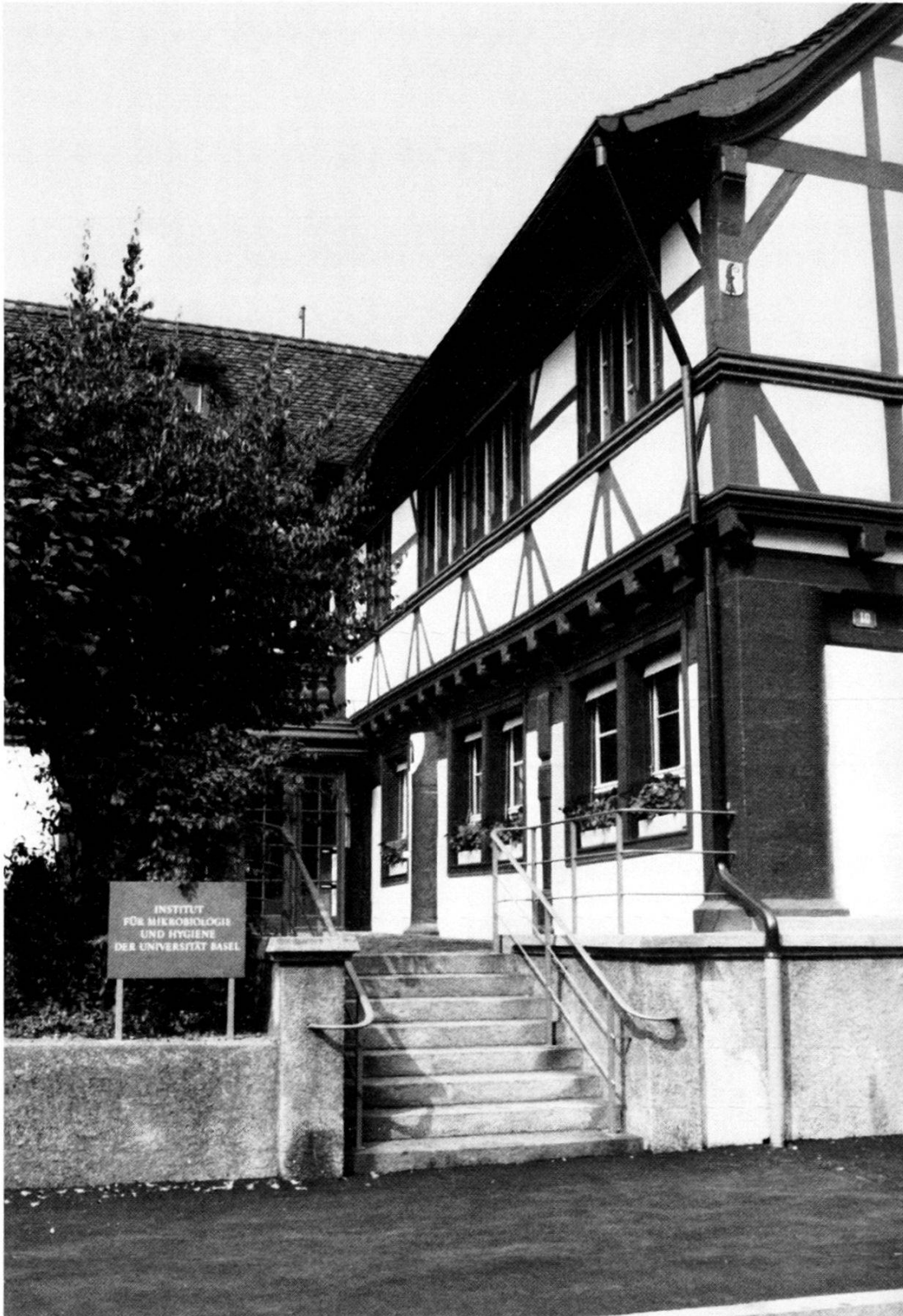
Abb. 24. Haupteingang des Stachelschützenhauses. Heutige Situation. Der 1546 als ältester Teil des Gebäudes errichtete Mitteltrakt.
