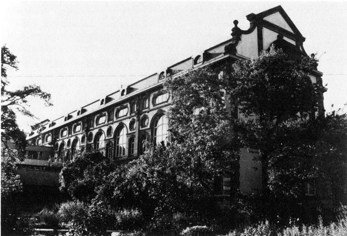
Abb. 30. Universitätsbibliothek Basel 1896, Südfassade des Magazins, aktueller Zustand.
