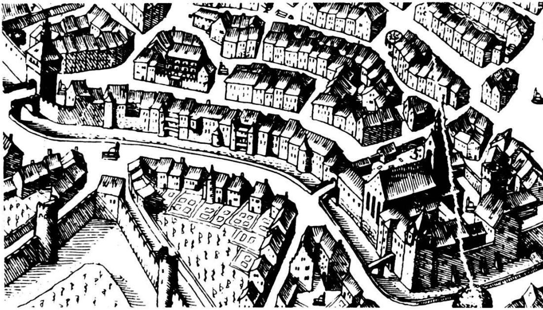
Abb. 13. Leonhardsgraben 39–43, 47, 59, 1980/31/9/13. Der Leonhardsgraben im 17. Jh. Ausschnitt aus dem Merianplan, Ansicht von Südwesten. – Aufnahme: Staatsarchiv Basel.
