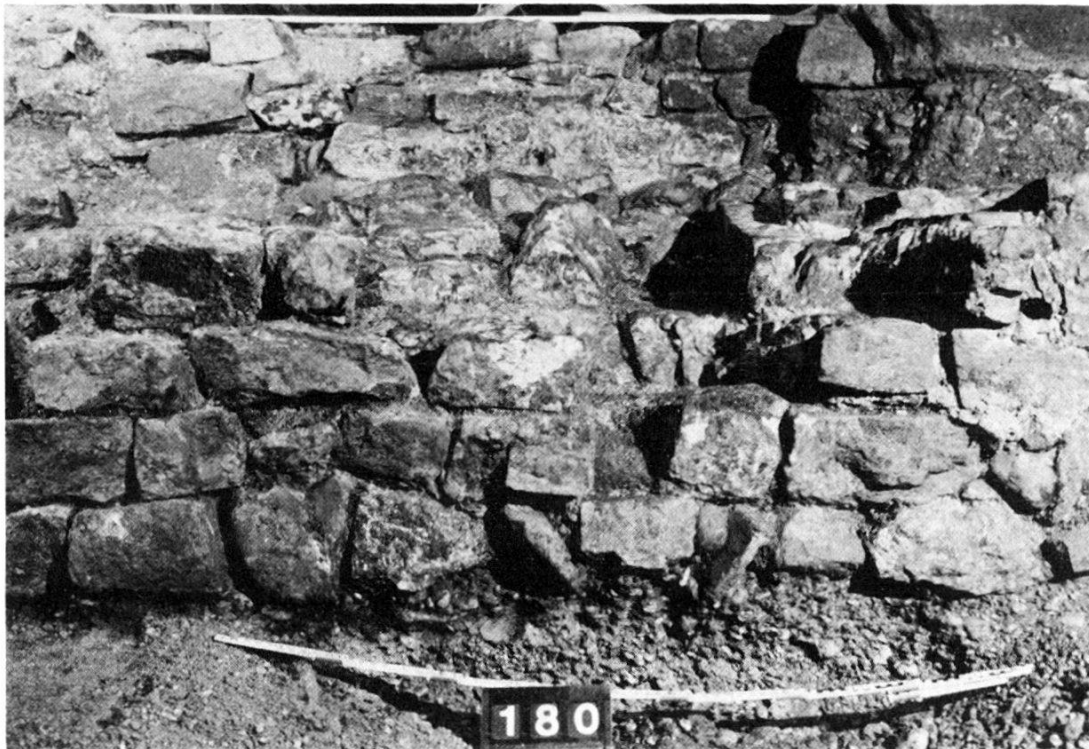
Abb. 45. Schneidergasse 2, 1982/3. Phase 1: Böschungsmauer aus weitgehend trocken versetzten Quadern (Abb. 44, A). Im Hintergrund ist die jüngere Stützmauer sichtbar. Blick gegen Westen. (Abb. 44, G).
