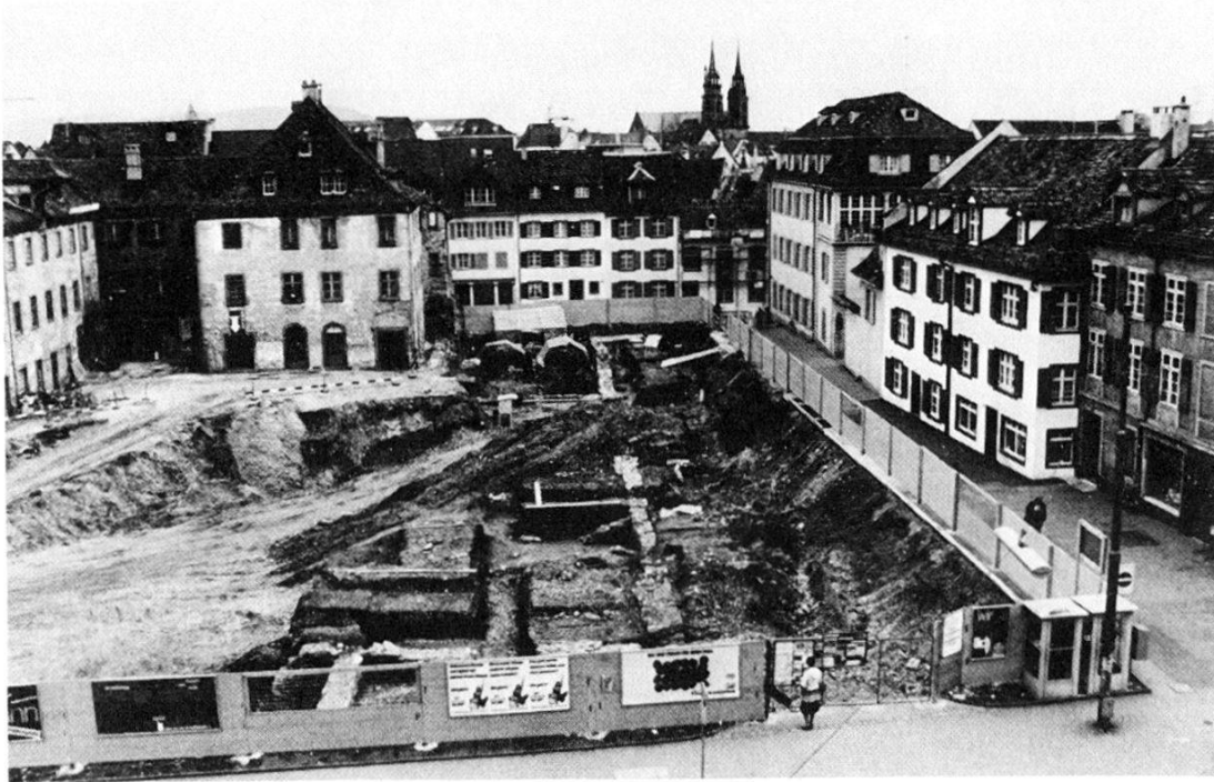
Abb. 47. Petersgraben 47–55, 1983/15. Überblick über das Rosshofareal vom Petersgraben Richtung Osten.
