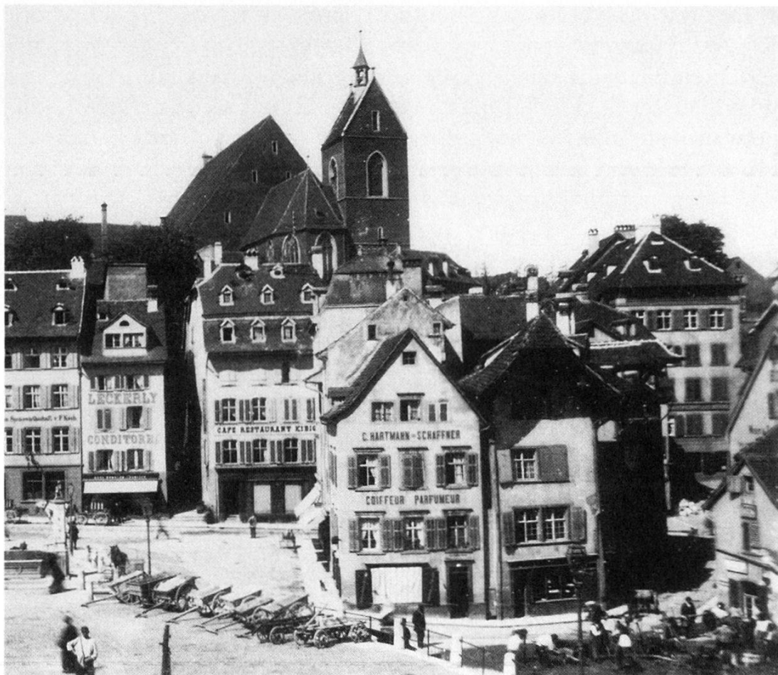
Abb. 7. Barfüsserplatz 22, 1987/10. Barfüsserplatz um 1880 (Blick gegen Lohnhof und Leonhardsberg). Vorne rechts das Eckhaus «Schützenmatte», Barfüsserplatz 22, im Giebeldreieck ist rechts ein aus Symmetriegründen aufgemaltes Fenster erkennbar. Beim «Springenden Hirschen» (rechts von der Eckliegenschaft) ist der vorstehende Krüppelwalm, wie er ursprünglich auch die Aufzugstüre der «Schützenmatte» überdacht hatte, sichtbar. – Foto: StAB.
