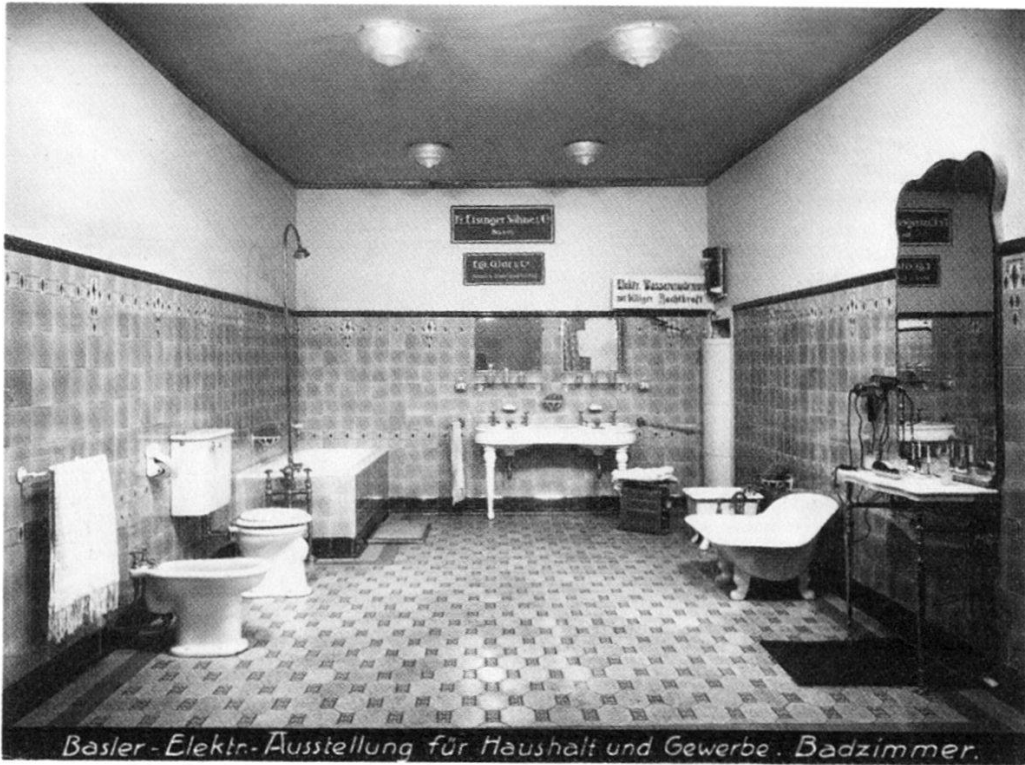
Nr. 7: Das Badzimmer warb vor allem für die elektrische Wassererwärmung mit billiger Nachkraft.
