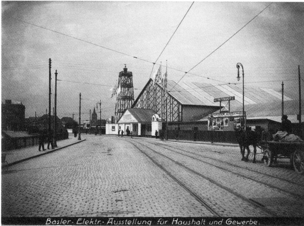
Nr. 1: Das Ausstellungzelt auf dem Kohlenplatz beim Bahnhof der Elsass-Lothringen-Bahn.
