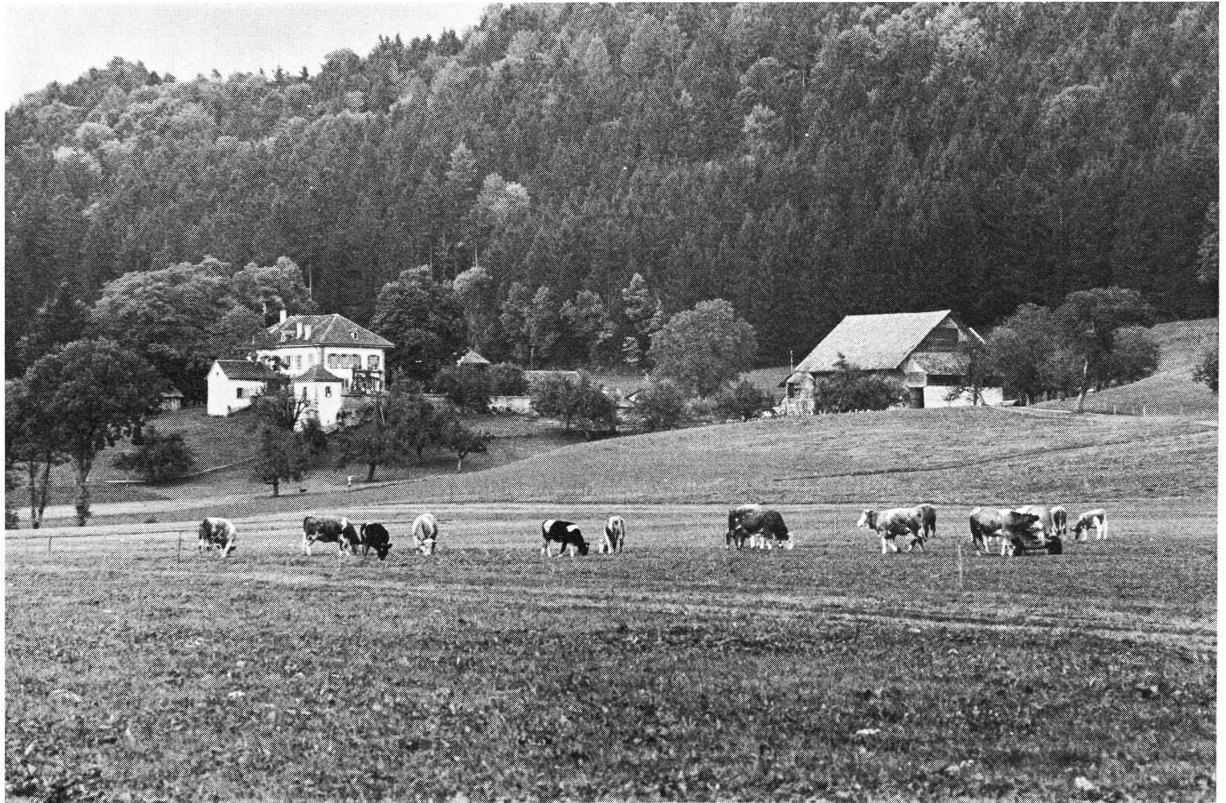
1. Brunnenberg, Ansicht aus Nordwest, vom Steinigen Weg her. Links Herrschaftshaus mit Kapelle und Gartenhäuschen, welche in den Abhang verbaut sind und mit der Stützmauer den Garten einrahmen (vgl. Abb. 4) (Photos Kantonale Denkmalpflege).
