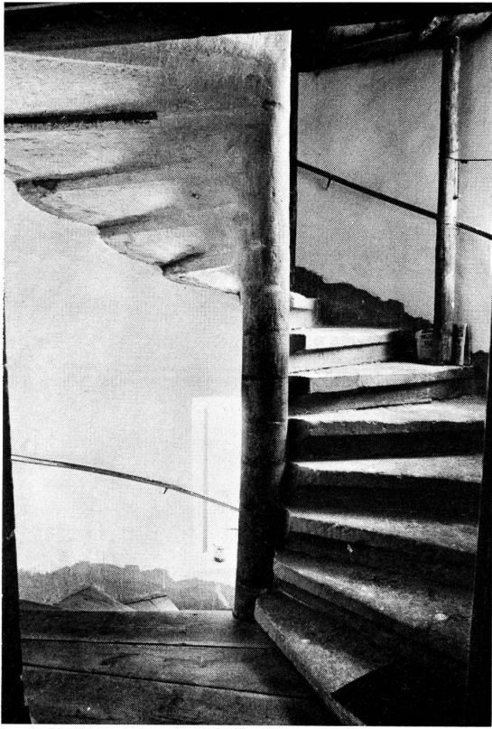
11. Gauglera, Treppenturm innen, im Zeitpunkt der Aufnahme Ausbesserungsarbeiten. Die einzelnen keilförmigen Stufen sind bei der Säule bogenförmig angeschnitten, wodurch sie von der Säule optisch abgesetzt sind (obwohl sie mit den einzelnen Säulenabschnitten in einem Stück gehauen sind).
