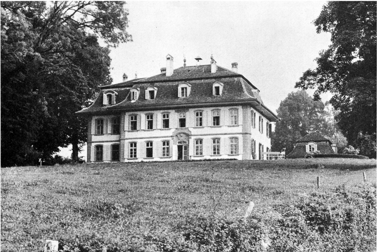
8. Vogelshaus, Ansicht aus Nordwest. Rechts im Hintergrund Nebengebäude, dem links hinten ein gleiches entspricht.
