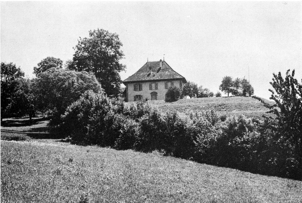
6. Tschüpru, Ansicht aus Nordost. Im Vordergrund stark abfallendes Gelände.
