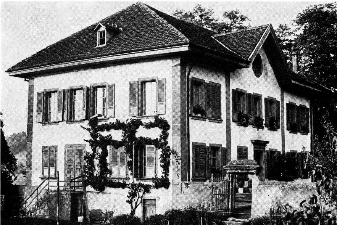
4. Brunnenberg, Ansicht aus Südwest. Im Vordergrund rechts Gartenportal und -mauer (vgl. Abb. 1).
