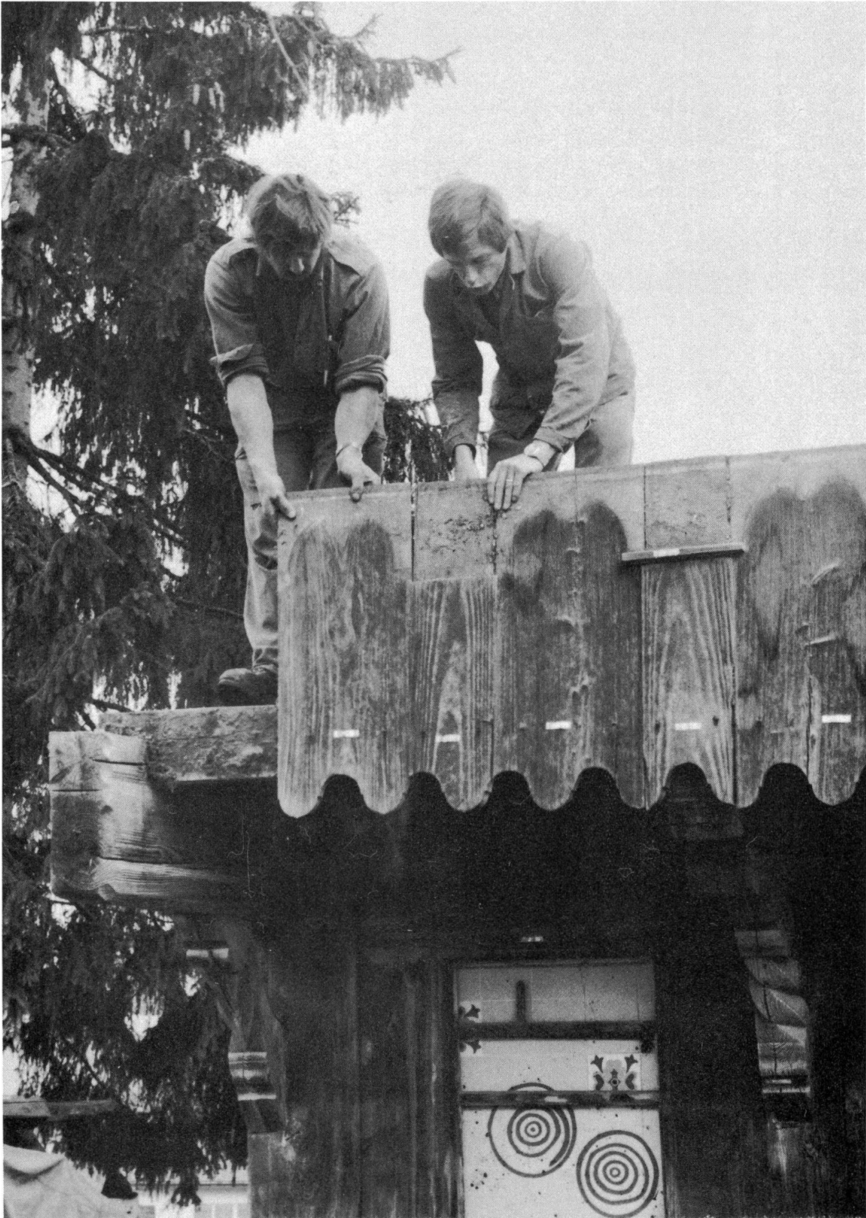
9 Die systematisch nummerierten Einzelteile werden sorgfältig demontiert. Dank der Elementbauweise, die keine Erfindung unserer Zeit ist, verspricht der Wiederaufbau auf dem Ballenberg zu einem faszinierenden Zusammenspiel zu werden. Berneroberrländer Handwerker vollziehen nach 200 Jahren ein zweites Mal den Schöpfungsakt ihrer Sensler Kollegen (Foto Bauernhausinventar, Freiburg)
