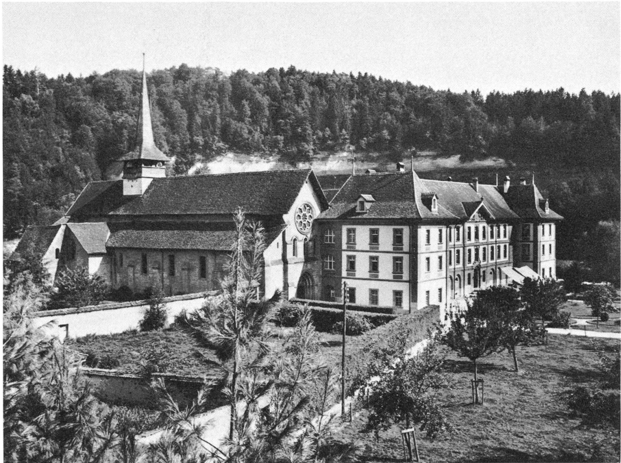
Im 1847 aufgehobenen Kloster Altenryf wurde 1859 das Kantonale Lehrerseminar eingerichtet. Eine deutsche Abteilung wurde allerdings erst 1909 eröffnet. Nach der Rückkehr der Zisterzienser verließ die letzte Klasse Altenryf 1940 (Foto J. Mülhauser, Inventar der Kunstdenkmäler, Freiburg um 1977/78)
