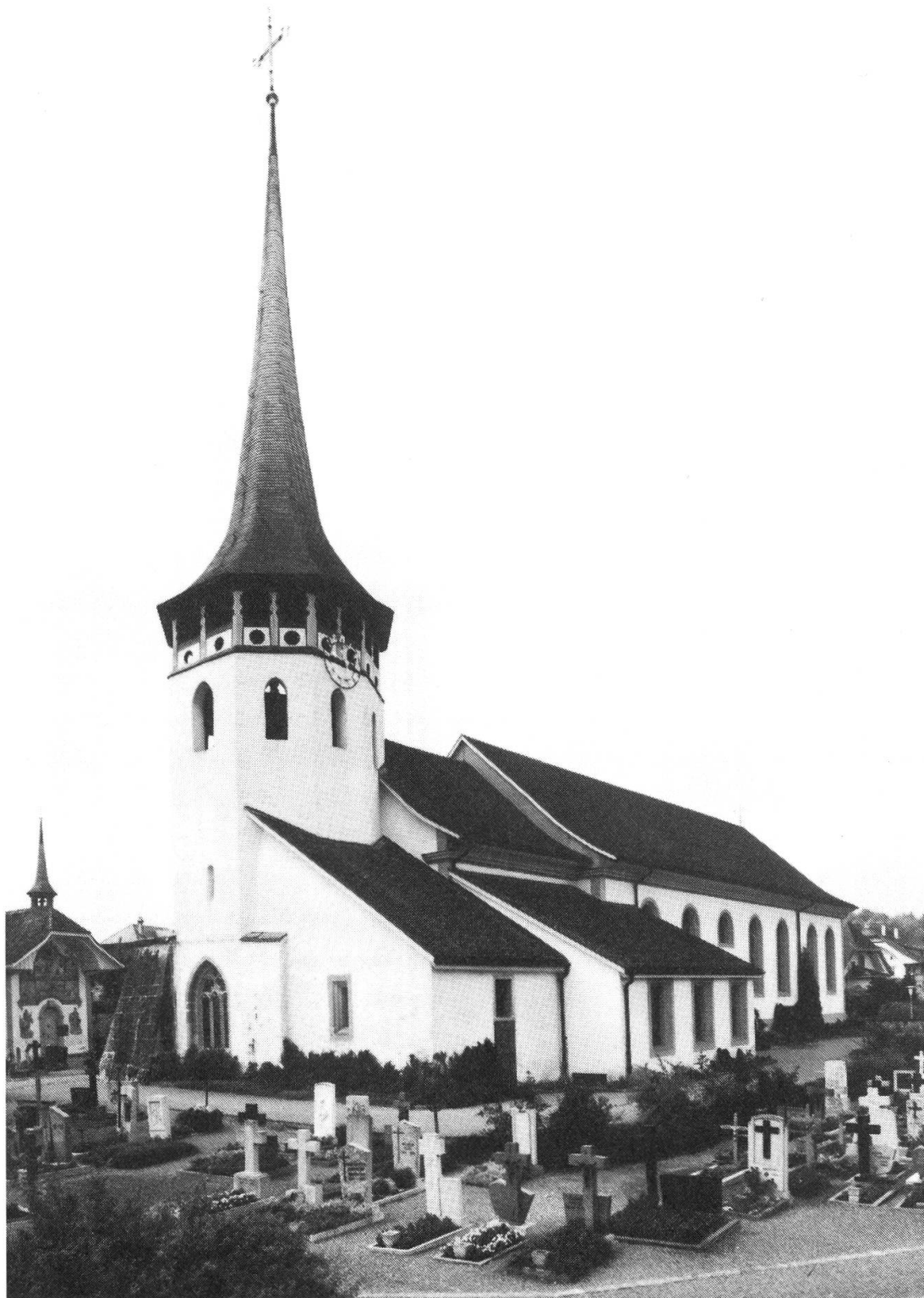
Zustand nach der Restaurierung 1965–1968: Besonders verändert wurde das Schiff durch Verlängerung um zwei Fensterachsen, ebenso wurde der Anbau auf der Nordseite des barocken Chors zur Sitzplatzgewinnung vergrößert.
