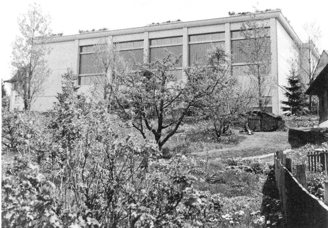
Die neue Mehrzweckhalle aus dem Jahre 1977
