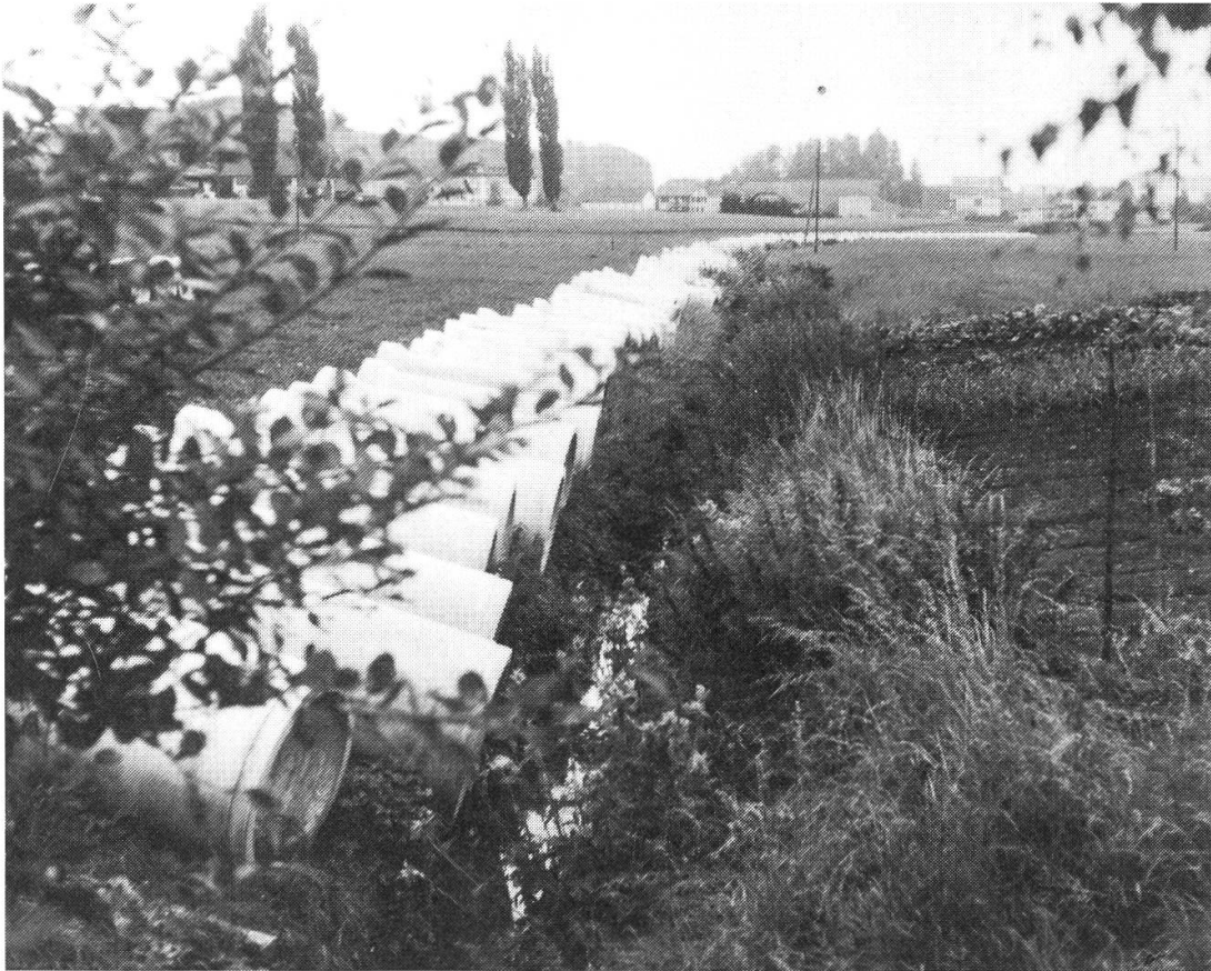
Verlegung von Rohren der ARA Taverna.
