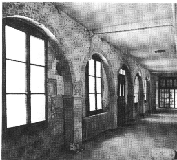
Fig. 54 Estavayer-le-Lac . Galerie du rez-de-chaussée de l'aile ouest du cloître
