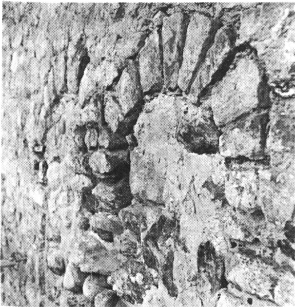
Abb. 78 Kerzers. Romanisches Doppelfenster im Turm
