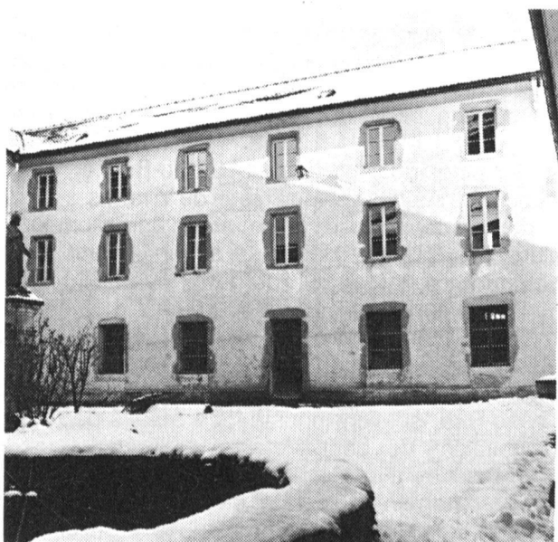
Fig. 53 Estavayer-le-Lac . Façade à l'ouest du cloître
