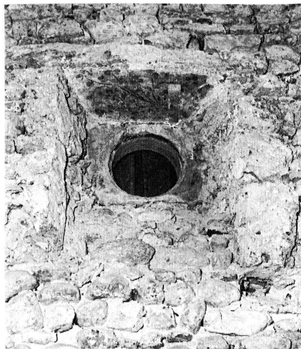
Fig. 85 Lully . Oculus dans le mur de chevet du choeur
