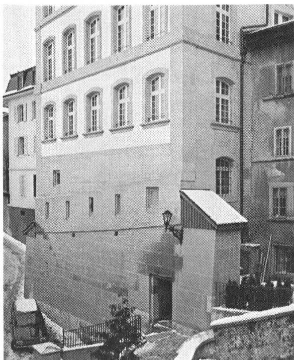
Fig.83 Fribourg, Grand-Fontaine. L'enceinte du milieu du XVII e siècle, état après la restauration de 1985
