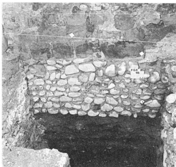
Fig.84 Fribourg, Quartier du Bourg/Grand-Rue. Angle nord-ouest des bâtiments avec la fondation maçonnée en cailloux et le parement de molasse de l'élévation
