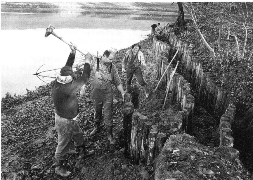
Abb. 14 Düdingen/Schiffenengraben. Arbeiten an der Nordspitze der Landzunge bei besonders niedrigem Wasserstand (November 1993). Eng nebeneinander eingeschlagene Lärchenpfähle schützen die Fundstätte auf einer Länge von 35 m
