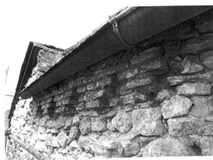
Fig. 39 Estavayer-le-Lac/Maison Griset de Forel. Détail de la frise de briques en dents de scie de la fin du XV e siècle
