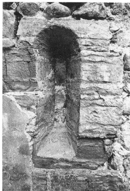
Fig. 82 Fribourg/Samaritaine 19-21. Mur SE, deuxième phase, fenêtre du deuxième étage
