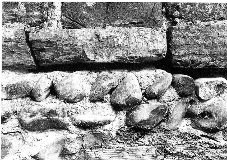
Fig. 80 Fribourg/Samaritaine 19-21. Mur SE, arase de la première phase
