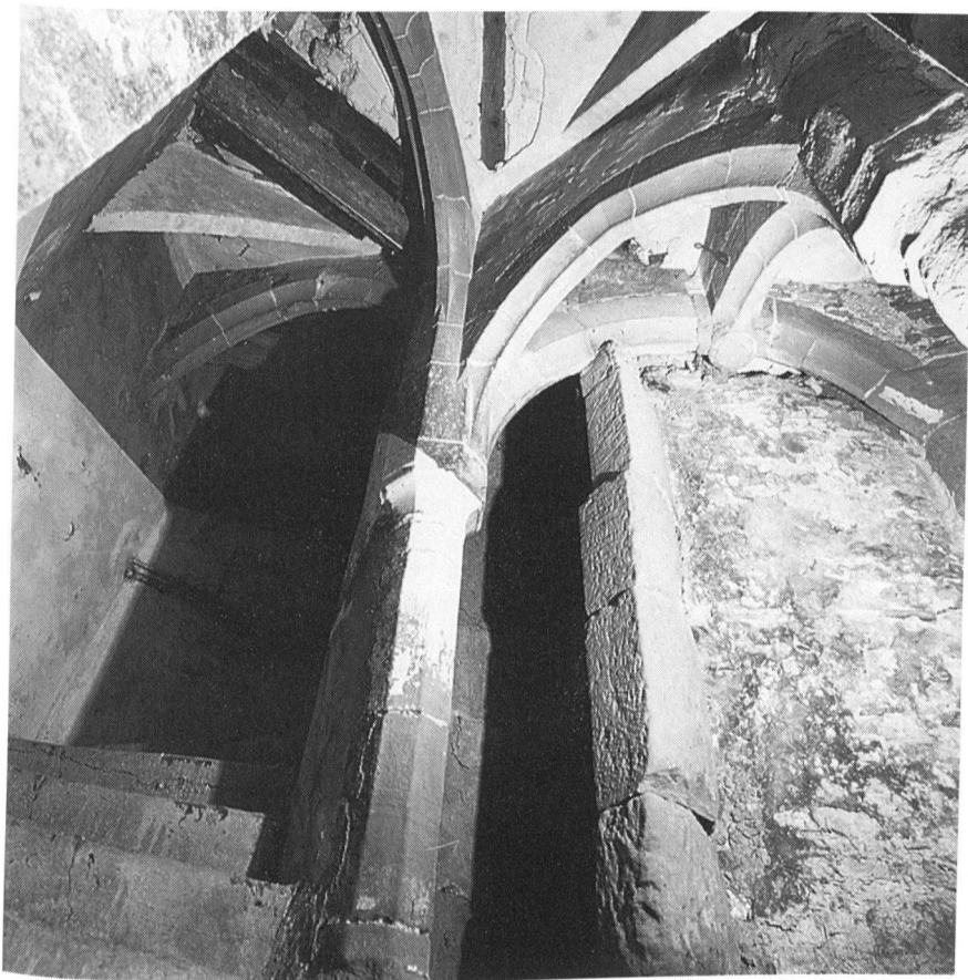
Fig. 68 Fribourg/Grand-Rue 32. Les supports de l'escalier du XV e siècle
