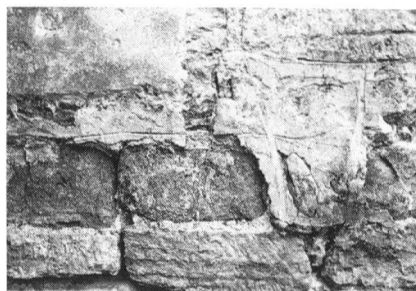
Fig. 83 Fribourg/Samaritaine 19-21. Mur SE, deuxième phase, rejointoyage en « pietra rasa »
