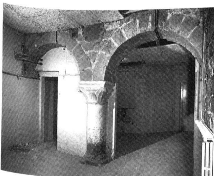
Fig. 62 Fribourg/Grand-Rue 32. Les arcs et la colonne de 1251 vus du nord
