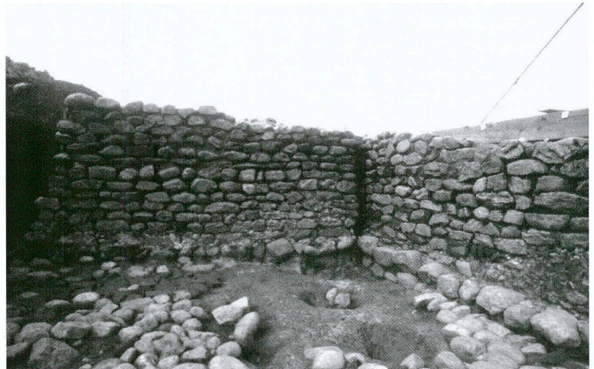
Fig. 3 L'angle nord-est de la cave avec le logement d'un poteau (P1)
