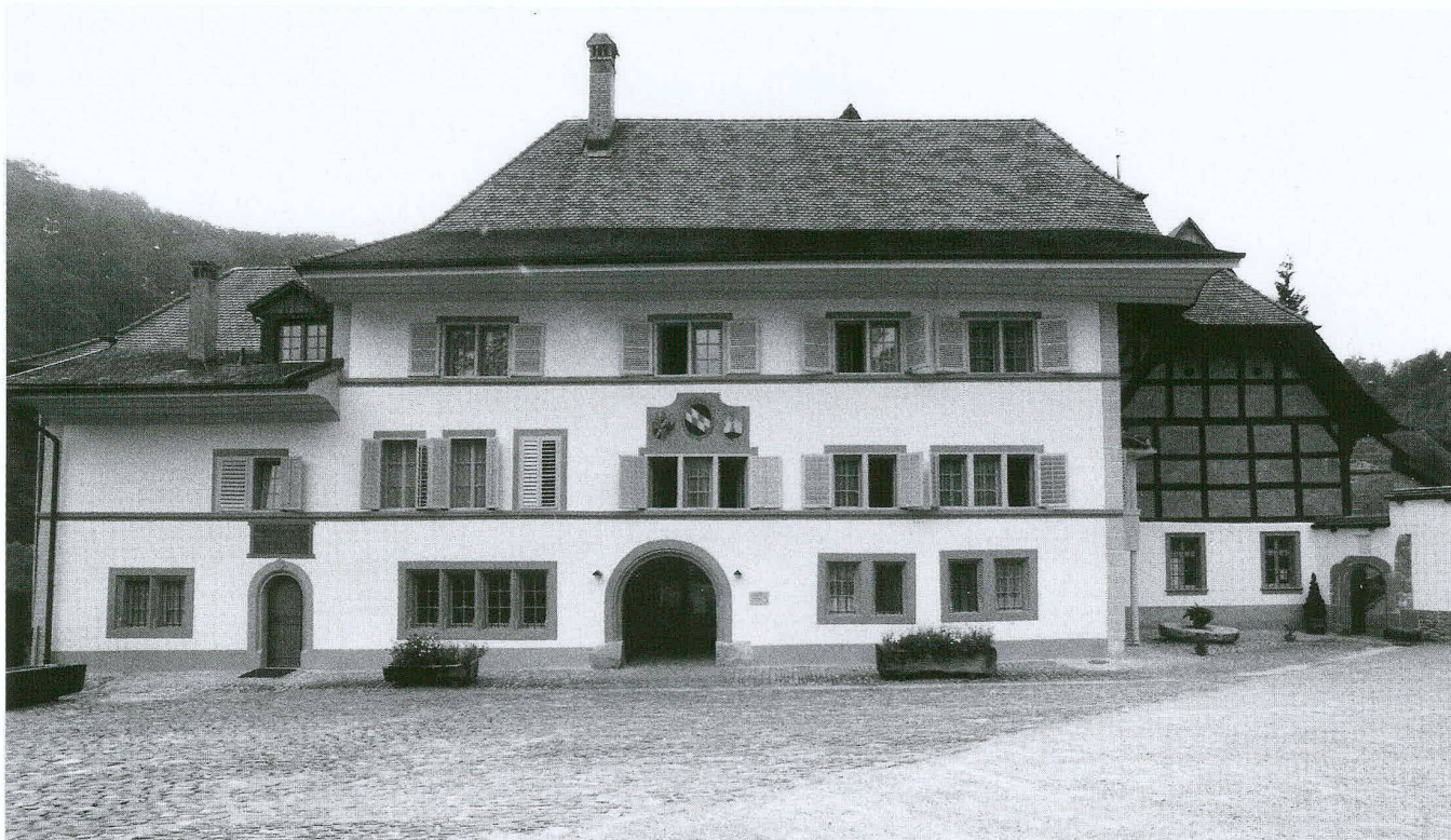
Fig. 17 Aumônerie, façade est après restauration
