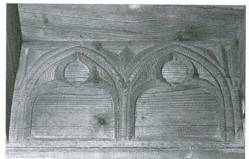
Fig. 16 Monastère, ancienne abbatale, rez, détail du plafond du XV e siècle
