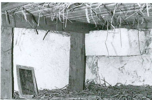
Fig. 15 Monastère, ancienne abbatale, rez, tablette de la cheminée médiévale
