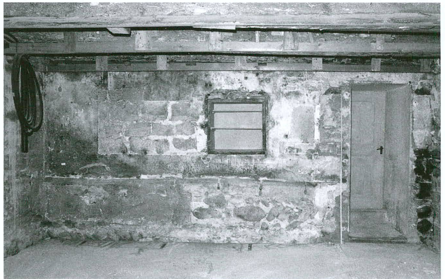
Fig. 3 Premier mur de clôture, partie ouest, parement externe
