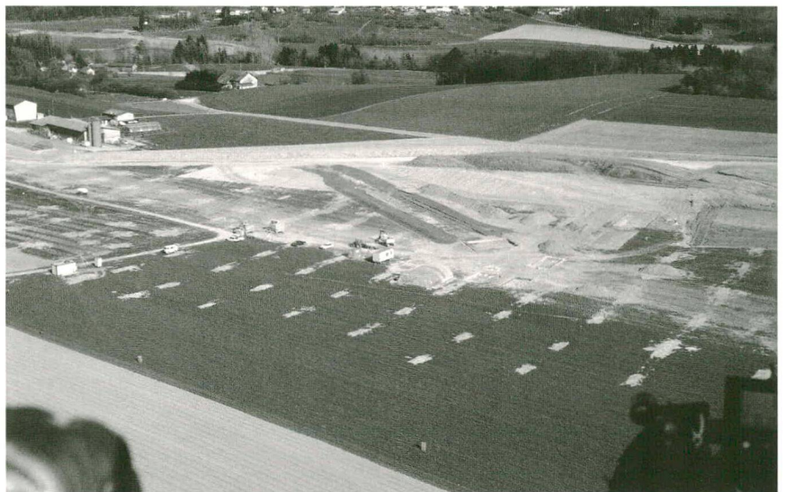
Fig. 1 Vue aérienne du site depuis l'ouest
