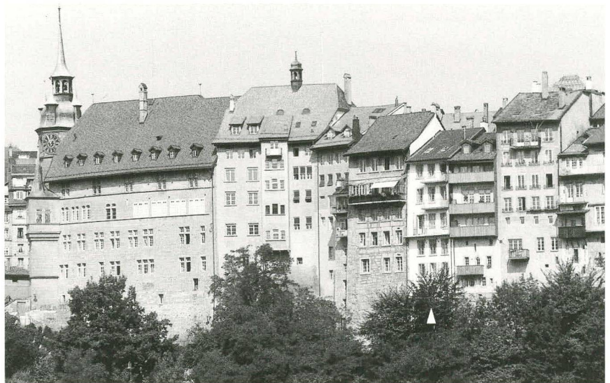
Fig. 1 Vue du sud après les travaux
