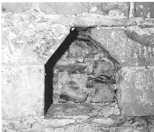
Abb. 7 Leuchternische im Kellerhals aus dem 13. Jahrhundert
