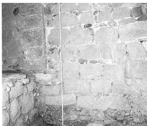
Abb. 8 Mauerwerk des 13. Jahrhunderts, Westmauer des westlichen Kellers
