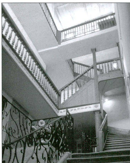
Fig. 10 Vue générale de la cage d'escalier
