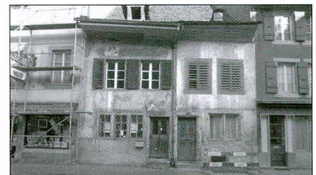
Abb. 16 Fassade zur Strassenseite
