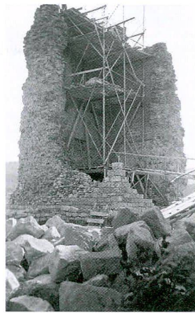
Fig. / Abb. 9 Les travaux de consolidation de 1947 Die Sicherungsarbeiten im Jahr 1947
