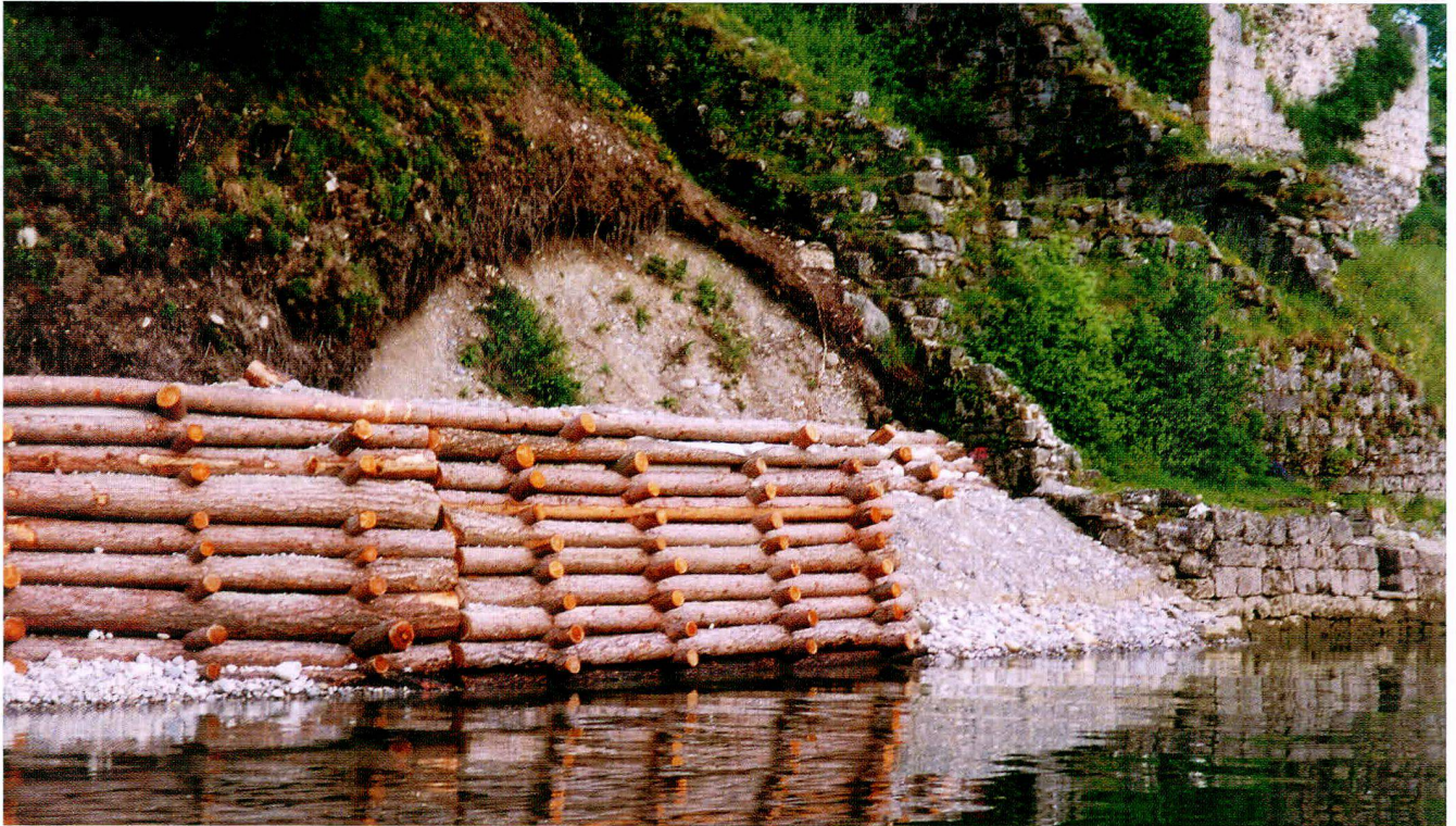
Fig. / Abb. 15 Les premiers caissons (étape 1, 1997) Die ersten Holzbarrieren (Etappe 1, 1997)
