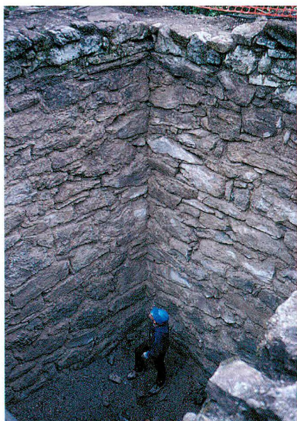
Fig. 2 Bossonnens/Château. Le donjon après vidange à la pelle mécanique
