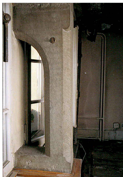
Fig. 13 Fribourg/Place du Petit-Saint-Jean 29. Colonne de trumeau du premier étage, XV e siècle
