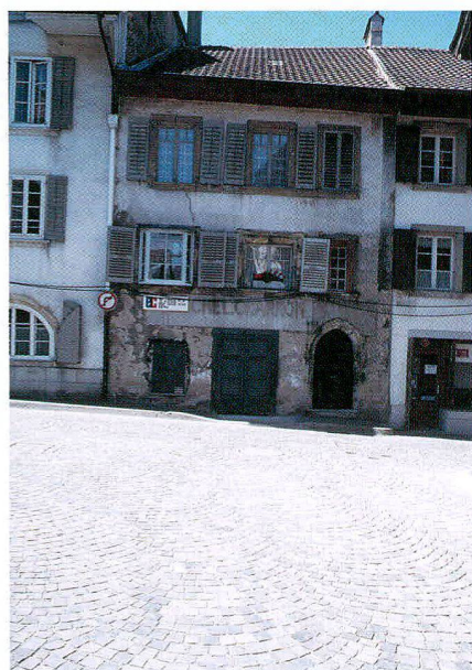
Fig. 9 Estavayer-le-Lac/Rue du Four 28. Vue de la façade principale
