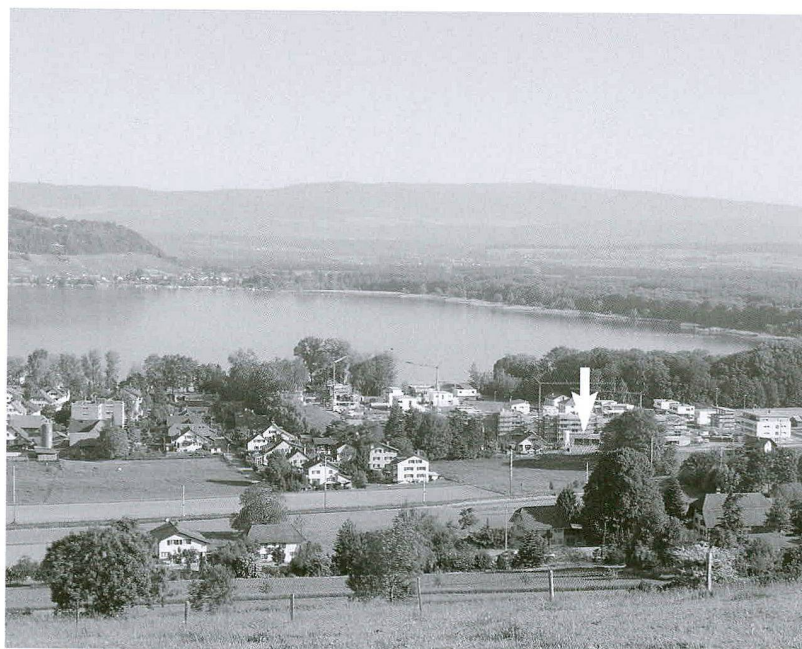
Fig. / Abb. 1 Vue générale du quartier de Montilier/Dorfmatte en cours de construction Gesamtansicht des Quartiers Muntelier/Dorfmatte während der Bauarbeiten
