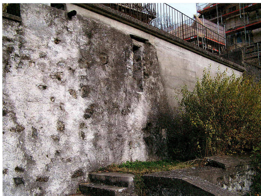
Fig. 13 Gruyères/Rue du Château 4. Vestiges de l'enceinte médiévale
