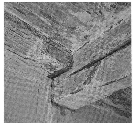
Abb. 15 Murten/Hauptgasse 19. Profile der Holzdecke im ersten Obergeschoss
