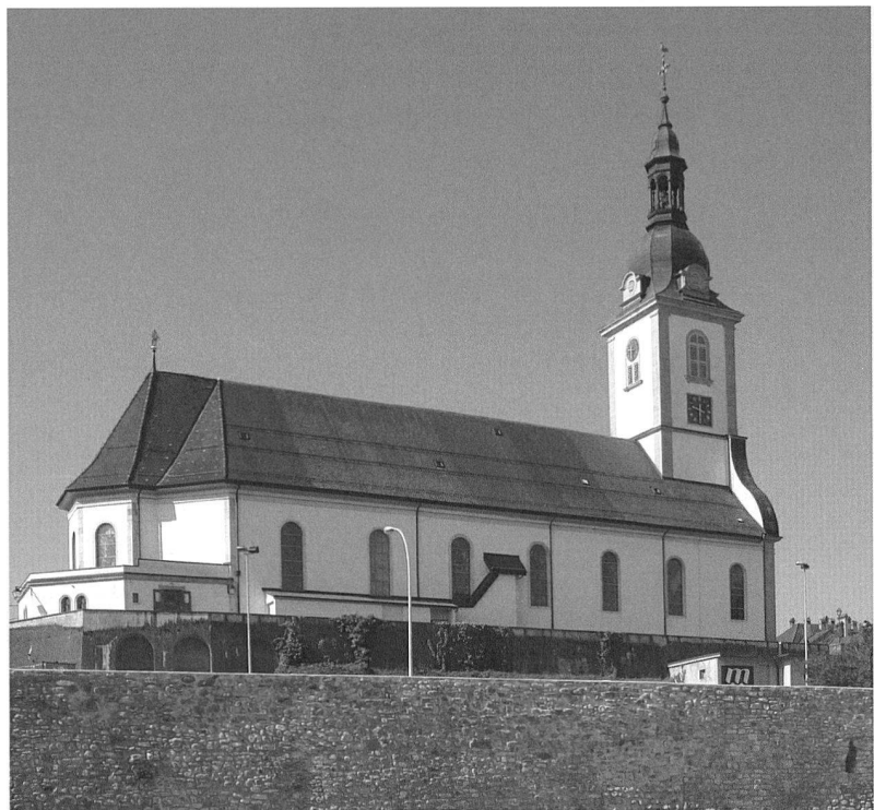
Abb. / Fig. 1 Bulle, Ansicht der Pfarrkirche von Nordosten L'église de Bulle vue depuis le nord-est
