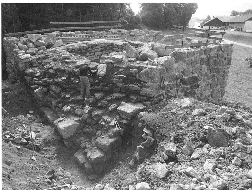
Fig. 2 Bossonnens/Château. Angle nord-ouest du donjon dégagé en vue des travaux de consolidation, avec le mur de pierres sèches constitué de moellons plus petits qui le recoupe
