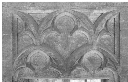
Fig. 17 Fribourg/Rue de la Neuveville 42. Fenestration aveugle du 2 e étage
