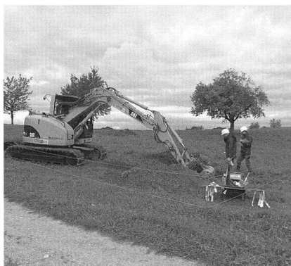
Abb. 29 Tafers/Bruchmatte. Während den maschinellen Sondierungen
