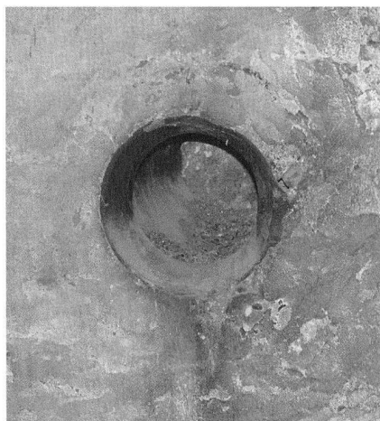
Fig. 7 Estavayer-le-Lac/Rue du Musée 12. Premier étage, pot inclus dans le mur est
