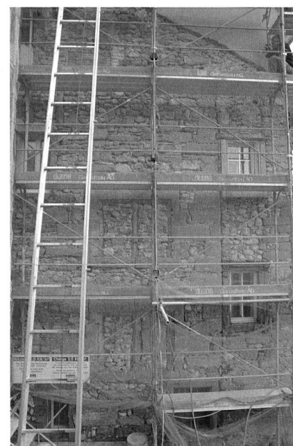
Fig. 15 Fribourg/Grand-Fontaine 31. Façade sud, reconstruction du XVI e siècle et pare-vent de la fin du XVII e siècle
