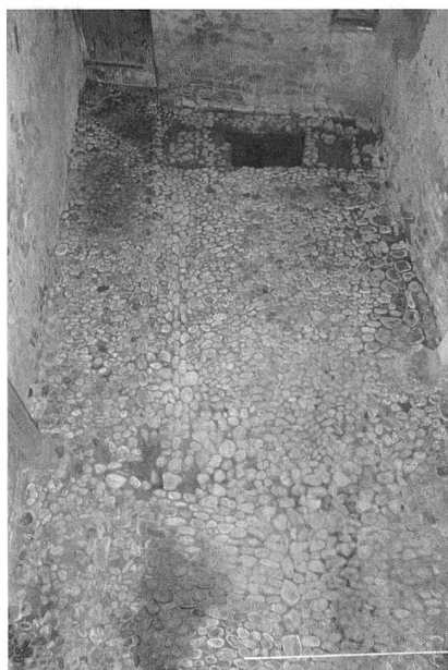
Abb. 24 Murten/Schulgasse 13. Pflasterung im Inneren
