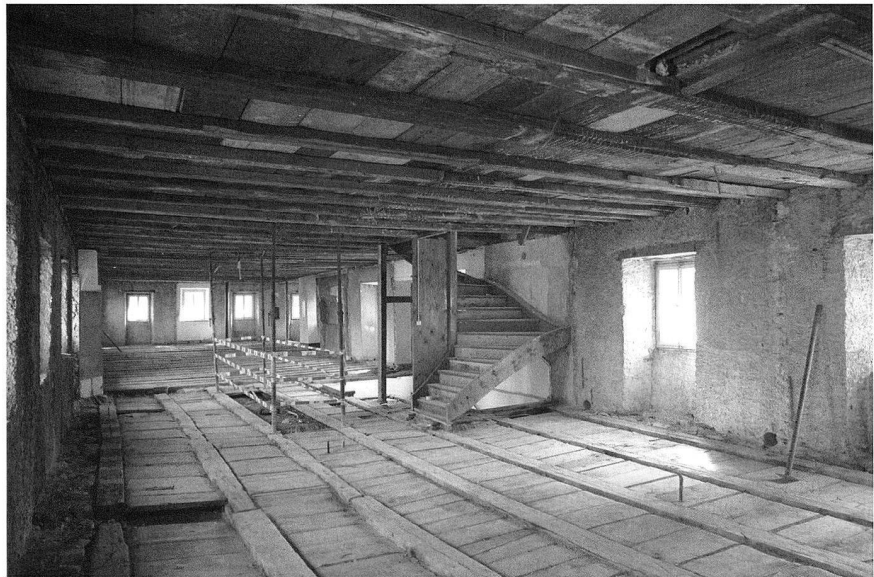
Fig. 3 Bulle/Couvent des Capucins. Premier étage entièrement vidé, vue générale du nord en septembre 2007
