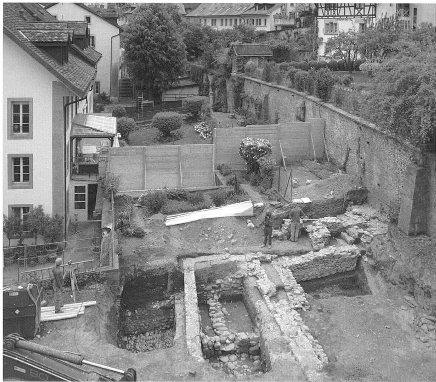
Fig.16 Fribourg/Rue de la Neuveville 5. Vue générale des sondages depuis l'est
