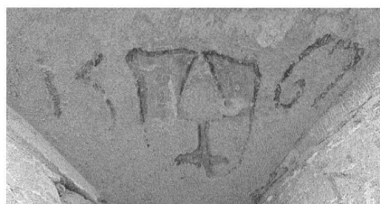
Fig. 14 Fribourg/Porte de Morat. Date et armoirie du troisième étage côté ville
