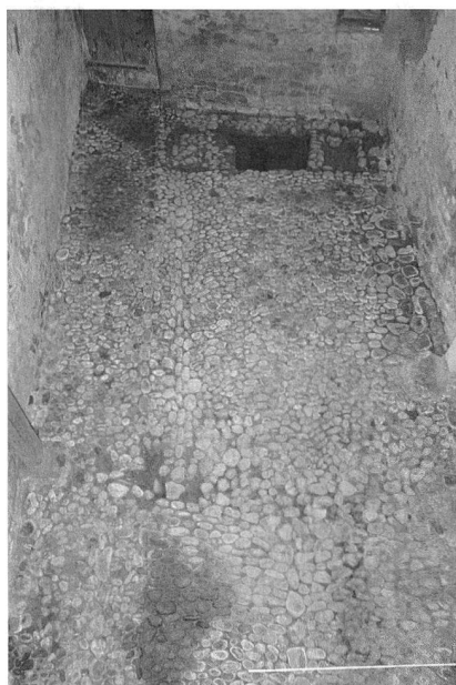
Abb. 24 Murten/Schulgasse 13. Pflasterung im Inneren
