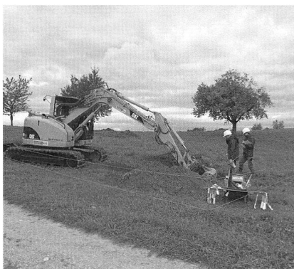
Abb. 29 Tafers/Bruchmatte. Während den maschinellen Sondierungen
