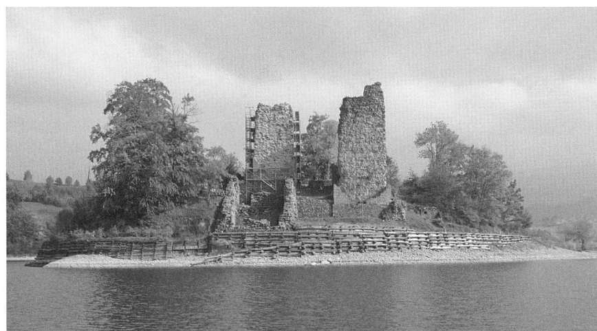
Fig. 25 Pont-en-Ogoz/Vers-les-Tours. Vue générale de l'ouest, après restauration de la tour nord
