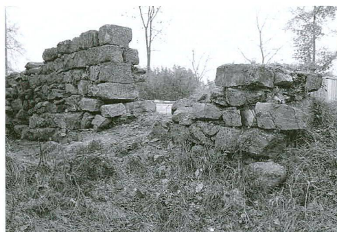
Fig. / Abb. 11 Mur de clôture oriental du château sud avec, au centre, le piédroit de porte encore conservé (état avant consolidation) Östliche Einfassungsmauer der südlichen Burganlage, in der Mitte der noch erhaltene Türpfeiler (vor der Konsolidierung)
