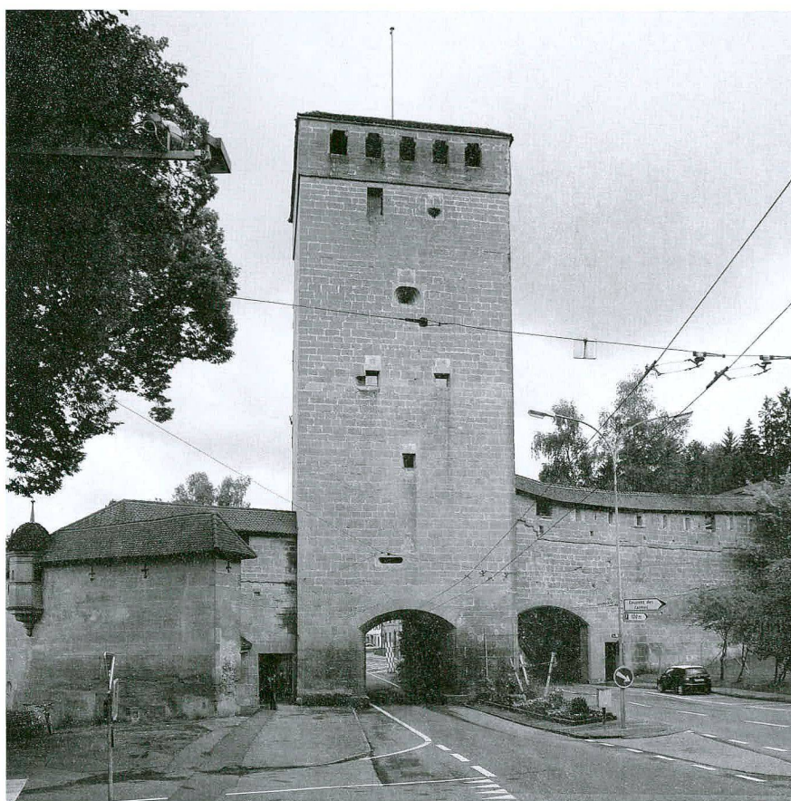
Fig. 1 La façade nord de la porte de Morat avant les travaux
