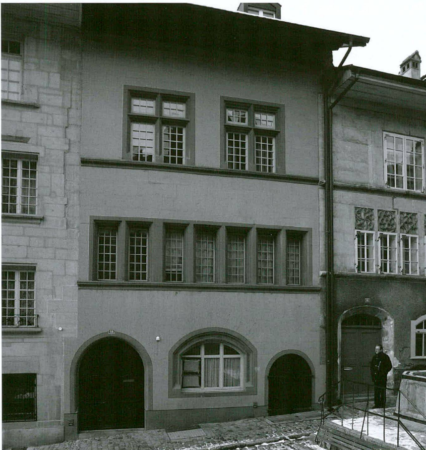
Fig. 12 Fribourg/Rue de la Samaritaine 18. Façade sur rue
