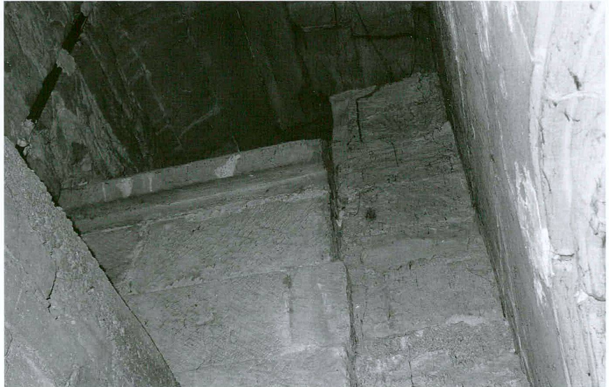
Abb. 19 Romont/Collégiale. Local situé entre le bas-côté sud et la chapelle sud-orientale du narthex avec des éléments de quatre phases de construction
