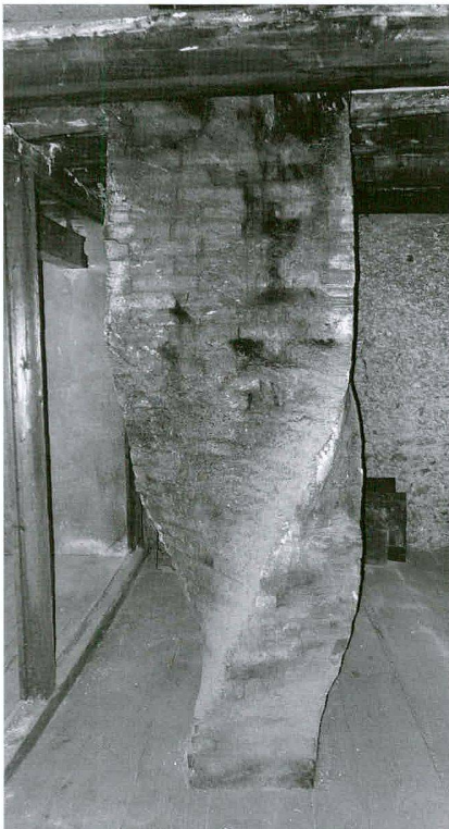
Abb. 14 Murten/Hauptgasse 6. Kamin im dritten Obergeschoss
