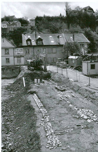
Fig. 11 Fribourg/Rue de la Neuveville 12. Vue générale du site depuis le nord-ouest
