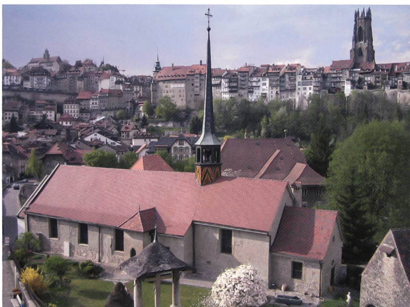
Abb. / Fig. 1 Freiburg, Kirche St. Johann, Gesamtansicht vor der Restau- rierung 2009 Fribourg, église St-Jean, vue générale avant les travaux de restauration de 2009
