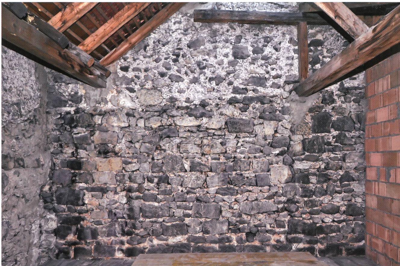
Fig. 8 Mur arrière (combles) avec traces encore visible d'une ancienne toiture
