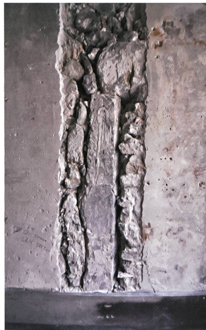
Fig. 3 Piédroit et départ de linteau dégagés dans le mur mitoyen avec le n° 37, au premier étage
