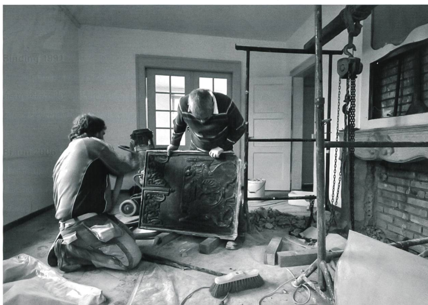
Fig. 3 Dépose de la taque de poêle: une opération délicate!
