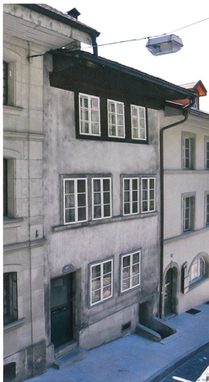
Fig. 1 Fribourg/Grand-Fontaine 29. Façade sur rue avant restauration
