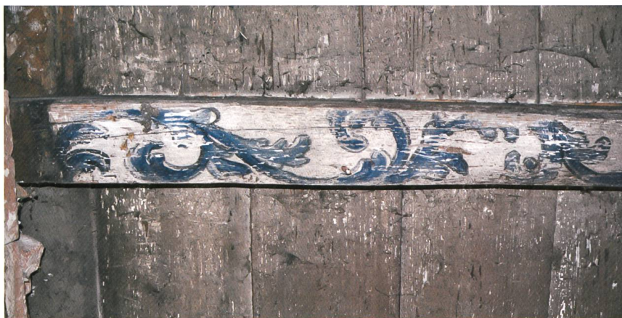
Fig. 12 Fribourg/Karrweg 2. Détail du plafond de la pièce principale du premier étage (fin du XVII e siècle)
