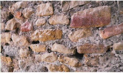
Abb. 5 Mauerung mit kleinrechteckigen Steinen aus einer römischen Ruine
