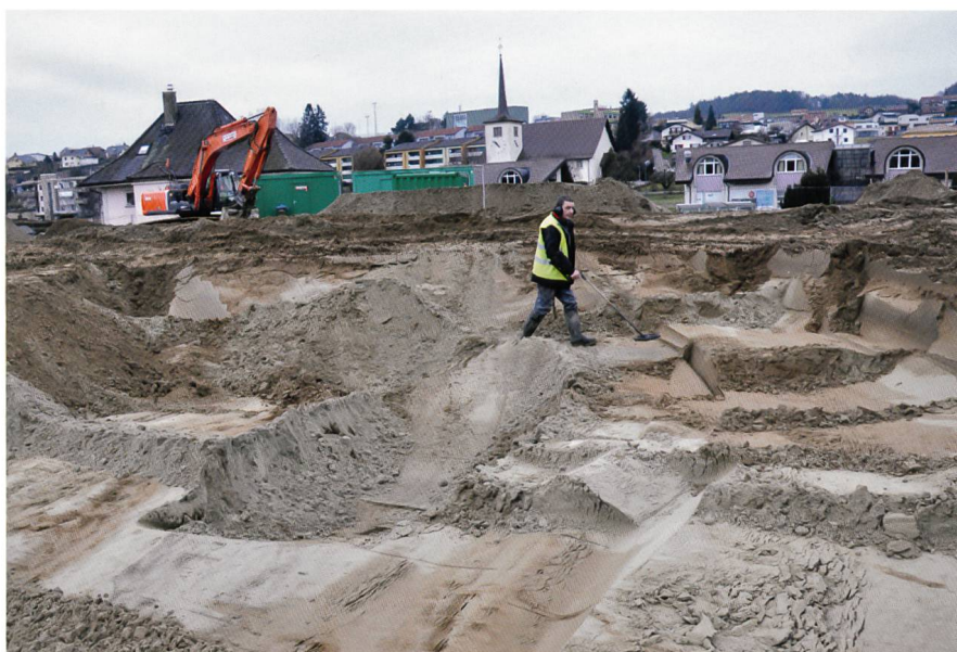
Fig. 3 Jean-Marc Egger à l'oeuvre sur un chantier de Courtepin
