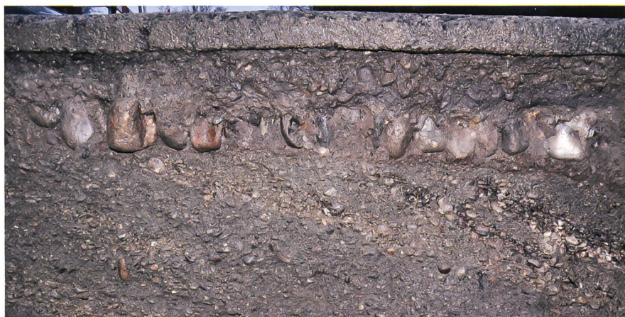
Abb. 17 Murten/Lausannestrasse. Alte Strassenpflasterung unterhalb der modernen Strasse
