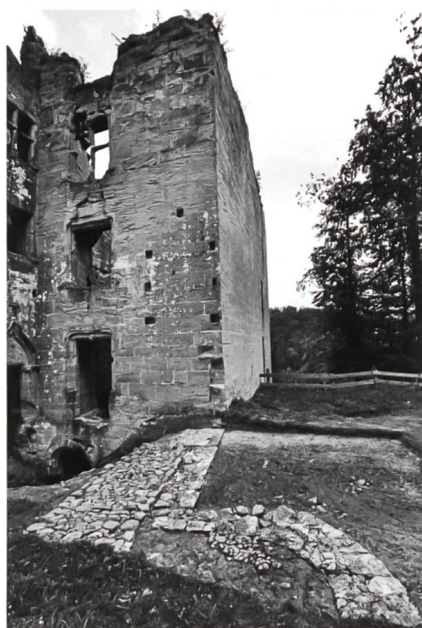
Fig. 5 Sondage 1: structures maçonnées annexes au pavillon de chasse et chemin en galets; à signaler, sur la façade ouest du pavillon, les empochements des poutres
