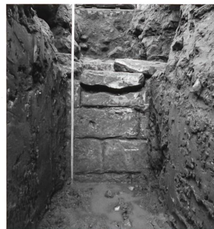
Fig. 8 Estavayer-le-Lac/Place de la Chaussée. Mur de soutènement aval du réservoir de 1428
