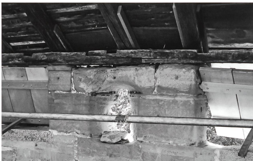
Abb. 20 Murten/Schaalgasse 6. Die Mauerschwelle im Bereich eines Mauerknicks. Blick nach Süden
