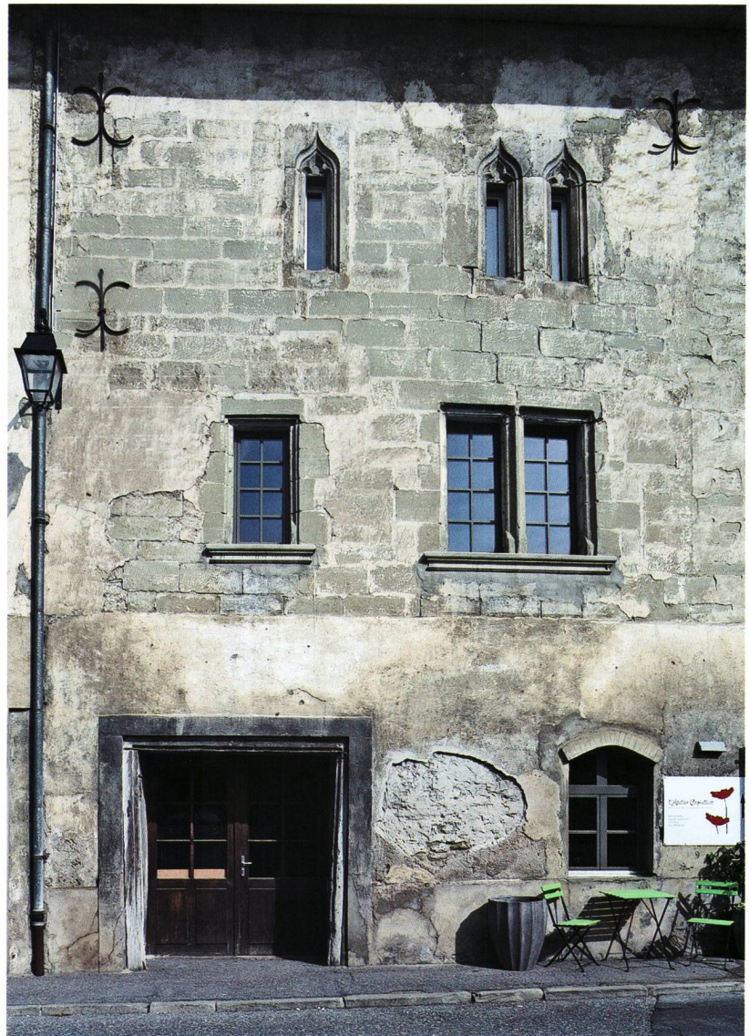
Fig. / Abb. 9 Maison de Prez-Maillardoz, bâtiment 2, façade orientale en 2015 Haus der Prez-Maillardoz, Gebäude 2, Ostfassade im Jahre 2015
