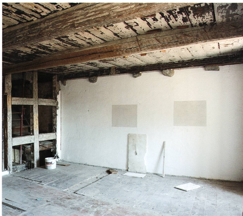
Fig. / Abb. 25 Maison de Prez-Maillardoz, bâtiment 3, premier étage, porte de communication avec le bâtiment 2, murée, 1434/1437 (au-dessus à gauche: la porte de 1406/1408) Haus der Prez-Maillardoz, Gebäude 3, erstes Stockwerk, zugemauerte Verbindungstür zu Gebäude 2, 1434/1437 (links oberhalb: die Tür von 1406/1408)
