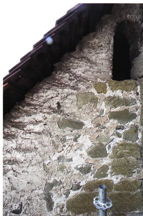
Fig. / Abb. 10 Aile orientale, détail du mur pignon nord avec la trace de la toiture médiévale Ostflügel, Detail des nördlichen Giebels mit Spuren der mittelalterlichen Bedachung
