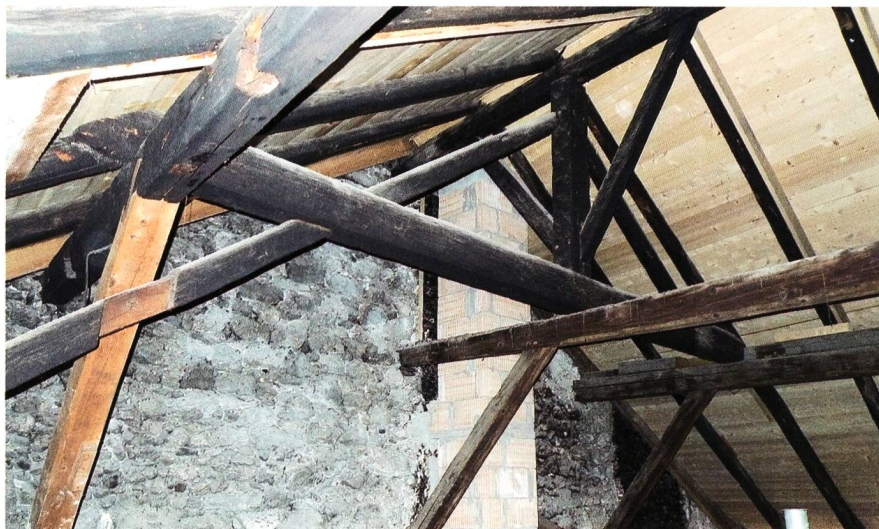
Abb. 6 Der Dachstuhl mit Blattsasse im Steigband und nachträgliche Abstützungen (alle modernen Bauteile sind aus hellerem Holz), Blick gegen die Brandmauer West
