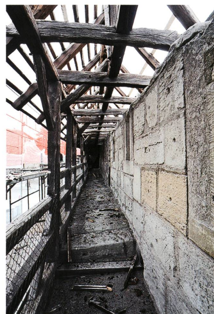
Fig. 9 Fribourg/Enceinte secteur tour du Blé. Chemin de ronde érigé en 1410-1412 et sa charpente de 1444/1445
