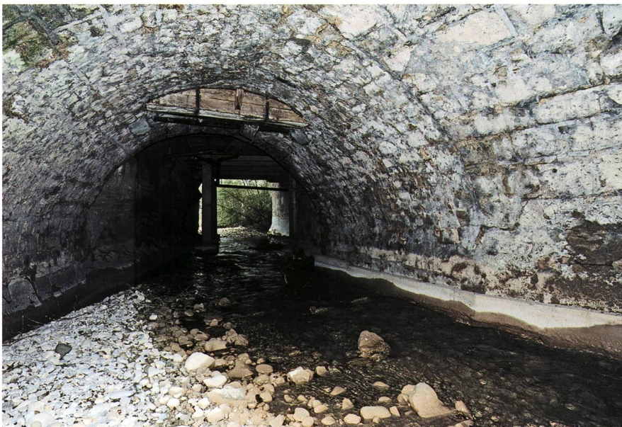
Fig. 13 Fribourg/Rue des Forgerons. Voûtes supportant la fontaine de la Fidélité et la chaussée sur le Gottéron
