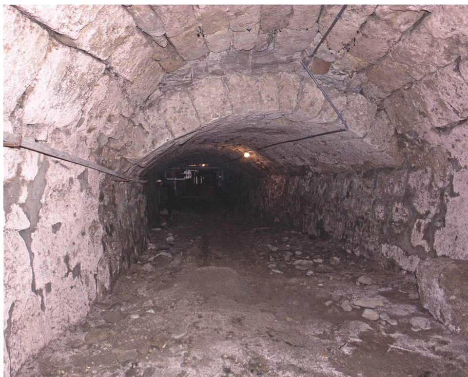
Fig. 9 Canal souterrain en tuf construit à la période romane
