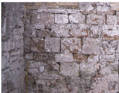
Fig. 3 Mur en molasse dans la paroi ouest de l'aile sud
