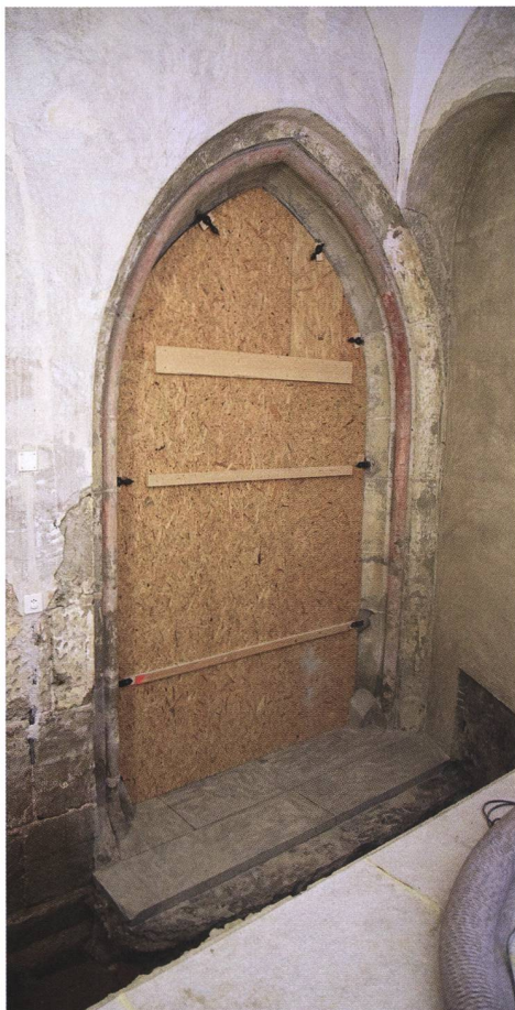
Fig. 12 Porte à arc brisé de la salle capitulaire (n° 3)
